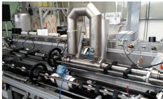
Obr. 3.22: Příklad zapojení hmotnostních průtokoměrů ČMI při funkční zkoušce (Obrázek uveřejněný s laskavým svolením firmy Justur, Stará Turá)
